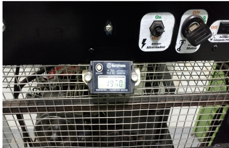
FIGURA 3 - Relógio horímetro instalado na bancada
